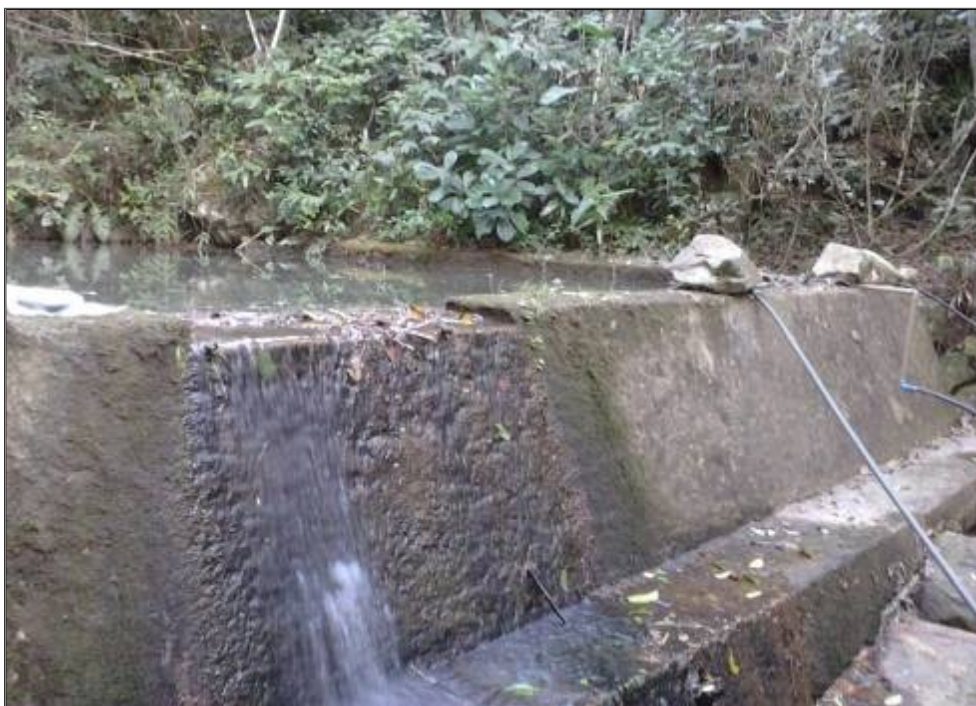
Figura 37 Rio Amazonas. Barragem para captação de água pelos moradores locais. Fonte: Autor.
