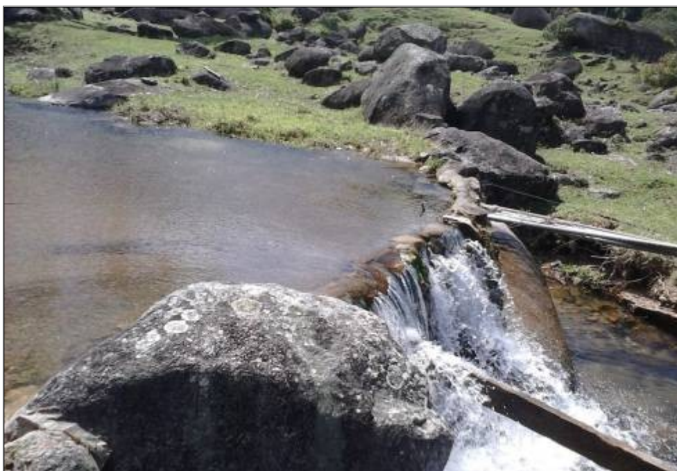
Figura 38 Rio 1 da Praia Vermelha. Barragem para captação de água para gerar energia. Fonte: Autor.
