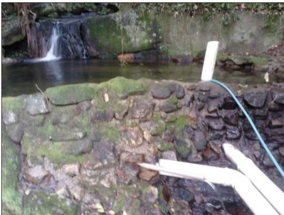
Figura 35 Rio 2 Praia Vermelha. Barragem de captação de água, no quadrante inferior direito, é possível observar a canalização. Fonte: Autor.
