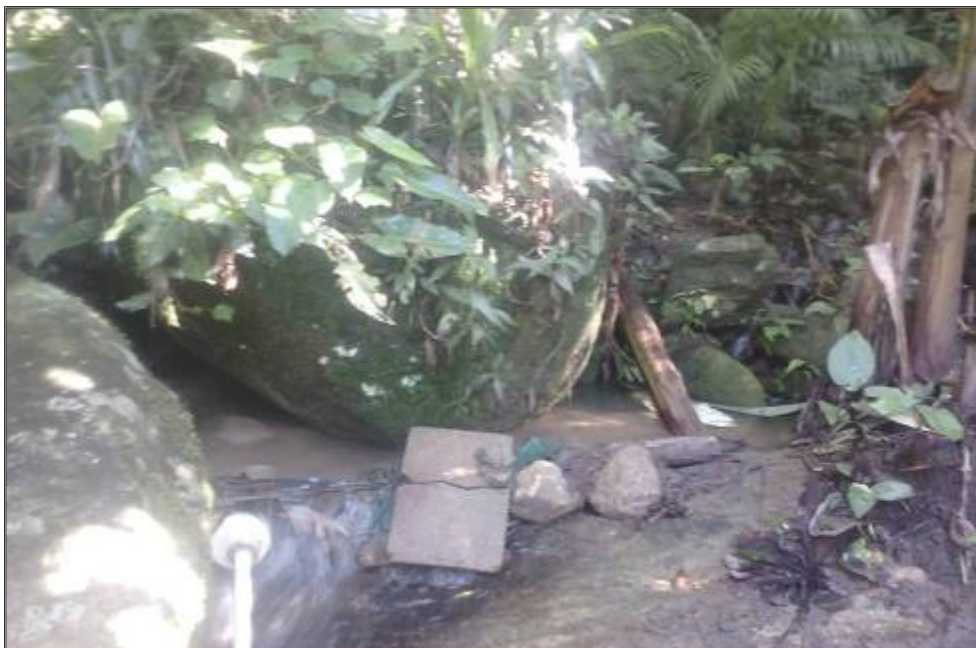
Figura 34 Rio Praia do Cantinho. No quadrante inferior esquerdo, é possível observar a captação de água por parte dos moradores locais, a jusante prosseguem mangueiras. Fonte: Autor.
