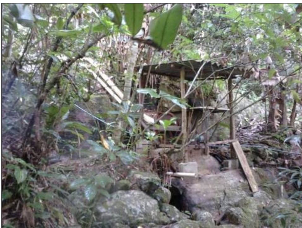
Figura 36 Rio 2 Praia Vermelha. Motor de bombeamento de água. Fonte: Autor.
