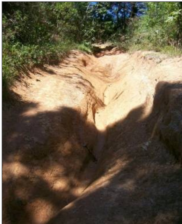
Figura 67 - Vala formada por erosão pluvial, de quase 1m de profundidade.
