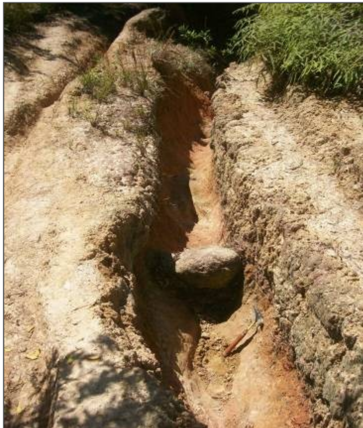
Figura 64- Erosão por escoamento Pluvial.
