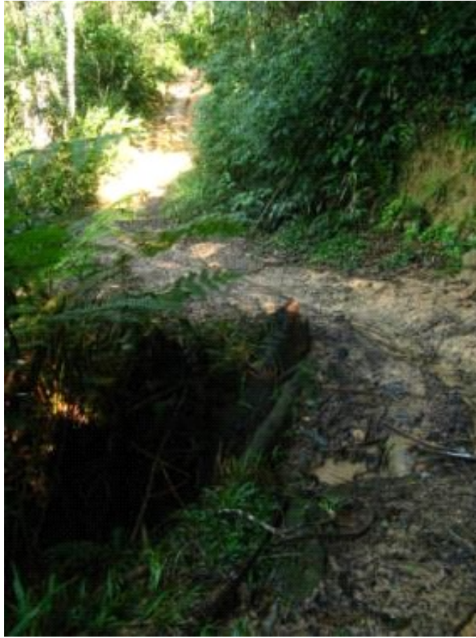
Figura 1.68: Problemas de drenagem e falta de estrutura na trilha do Divisor.
