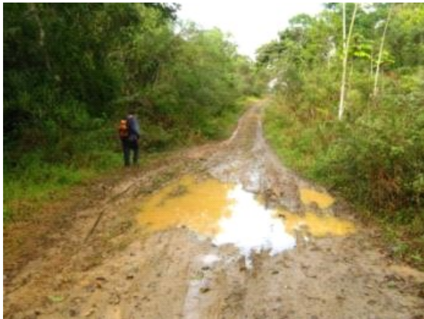
Figura 1.61: Problemas de drenagem, trilha do Divisor (trecho da estrada das antenas).
