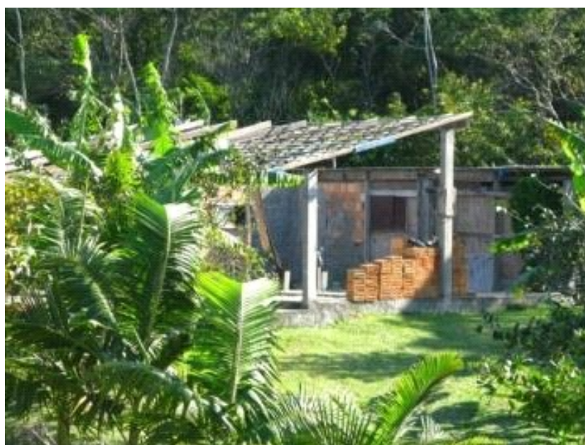
Figura 1.43: Propriedade em construção ou reforma.
