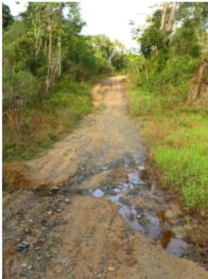
Figura 1.63: Problemas de drenagem, trilha do Divisor (trecho da estrada das antenas).
