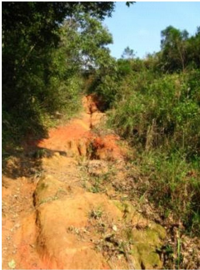
Figura 1.67: Processos erosivos, trilha do Divisor.
