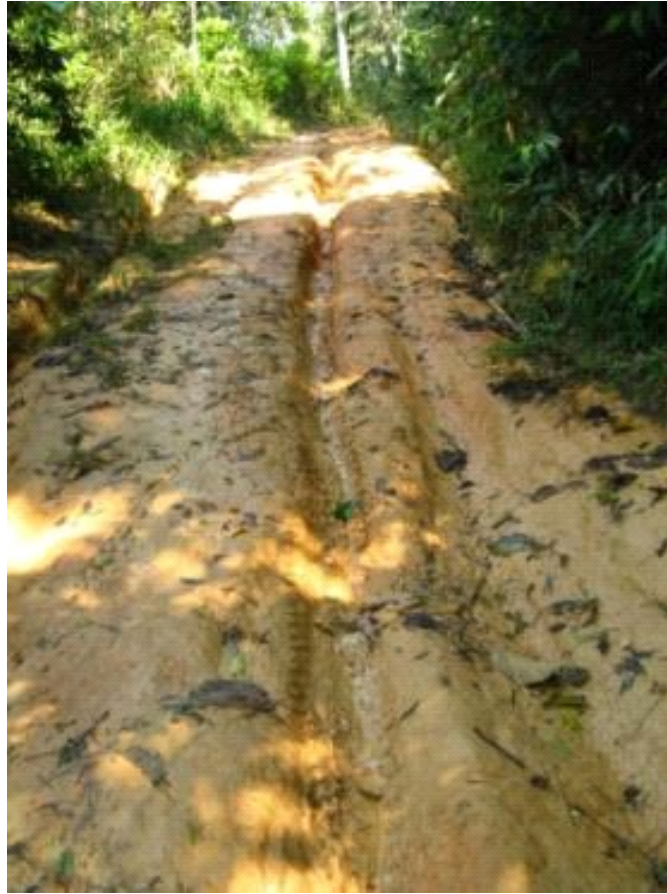
Figura 1.69: Evidência de processos erosivos acentuados pelo uso com motocicletas e jipes, trilha do Divisor.
