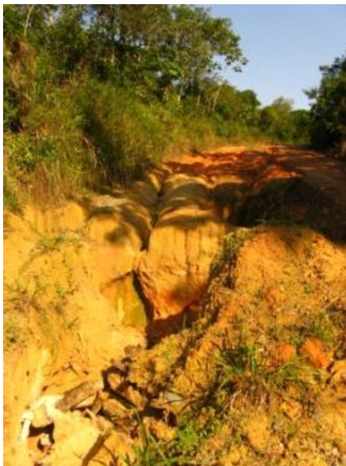
Figura 1.64: Processo erosivo avançado, trilha do Divisor (trecho da estrada das antenas).
