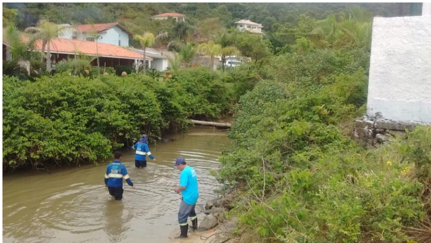
Figuras 12 a 17: Uso de barca para reparos na adutora
