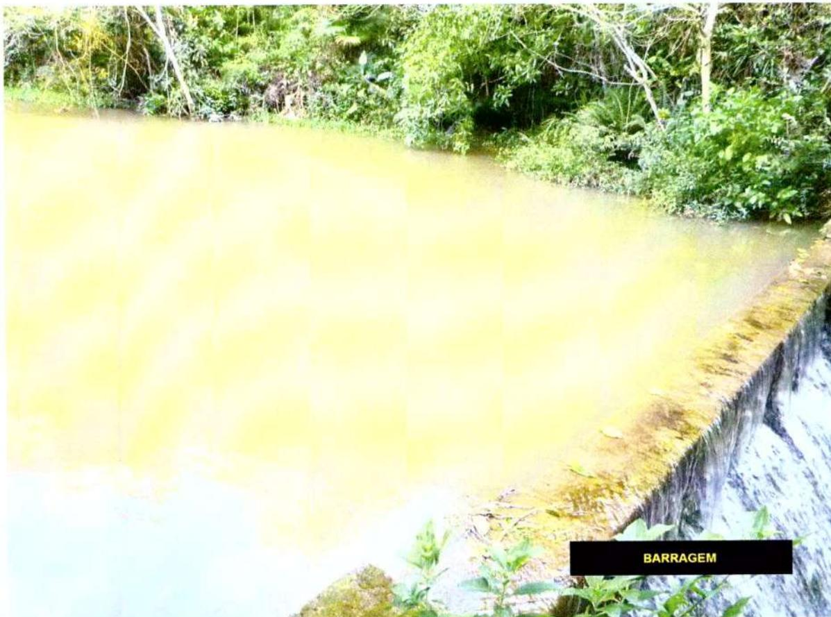
**Figura 09** – Vista da área de reservação da Barragem, foi possível constatar o assoreamento do tanque devido ao carreamento de sedimentos e matéria orgânica. A vegetação do entorno do tanque é formada por espécies herbáceas e rizomatosas características de áreas inundadas além de poucos indivíduos arbóreos em estado fitossanitário ruins, alguns sem vida.
