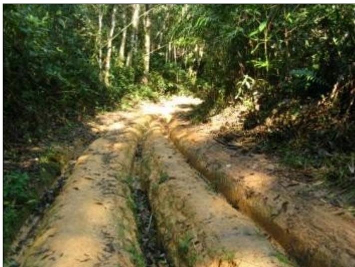
**Figura 1.71: Evidência de processos erosivos acentuados pelo uso com motocicletas e jipes, trilha do Divisor.**
