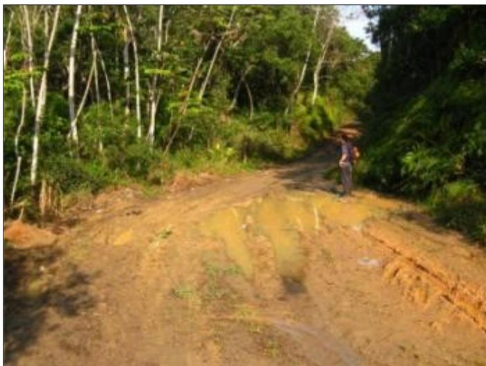
**Figura 1.62: Problemas de drenagem, trilha do Divisor (trecho da estrada das antenas).**
