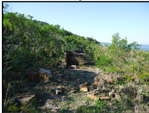
Figura 227 - Escombros de construção recente na Praia da Lagoa.
