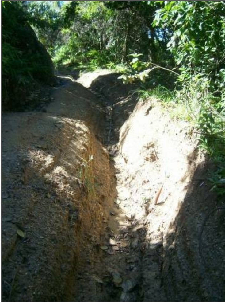
Figura 192 - Voçoroca formada por ação pluvial.
