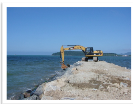
Figura 6 – Exemplo de execução de obra sobre enrocamento existente com escavadeira hidráulica
