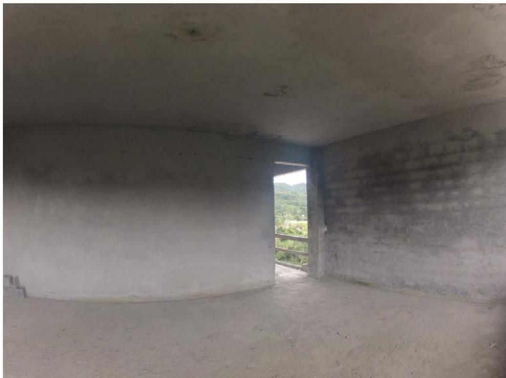
UMIDADE DAS PAREDES E TRINCAS DEVIDO A MÁ EXECUÇÃO DO ENCUNHAMENTO
