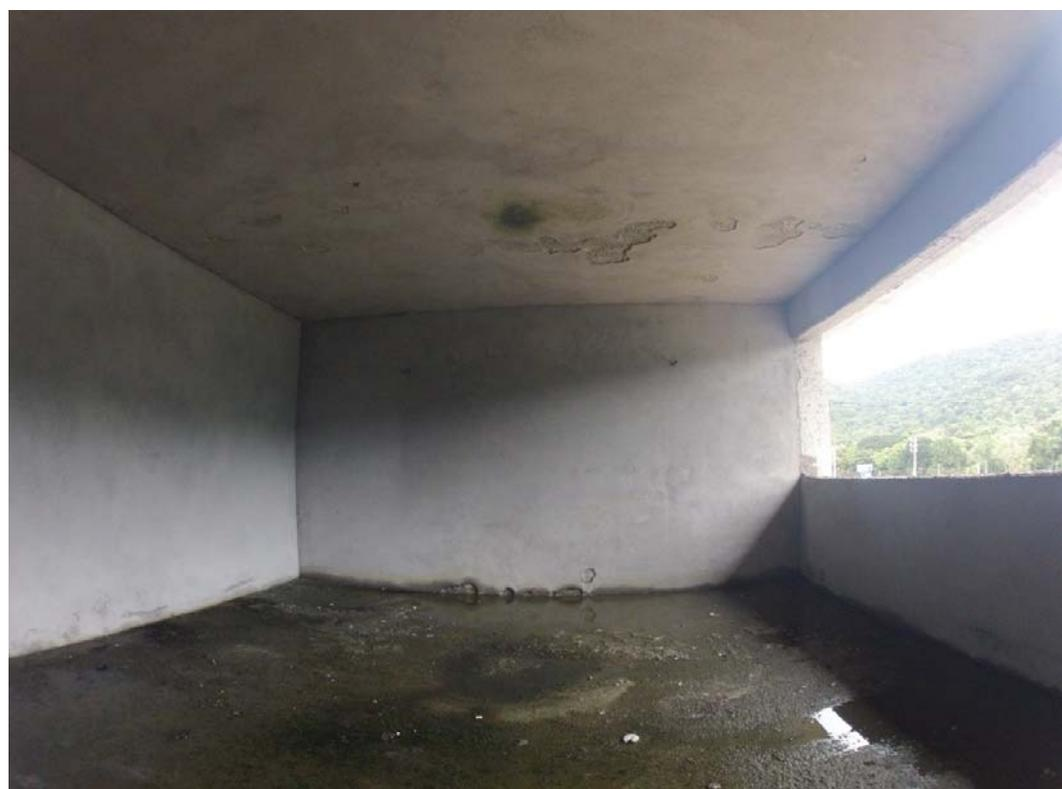
INFILTRAÇÃO CAUSANDO DANOS NAS LAJES E REVESTIMENTOS
