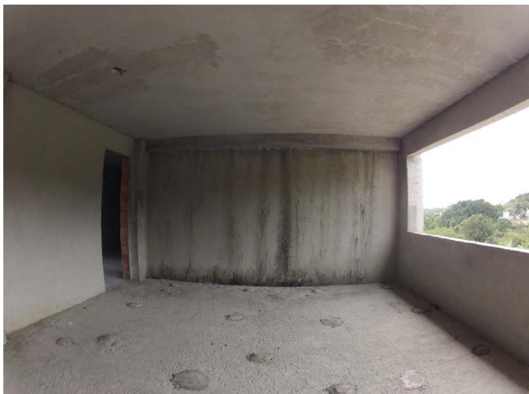
INFILTRAÇÃO PELA JUNTA DE DILATAÇÃO DO PRÉDIO
