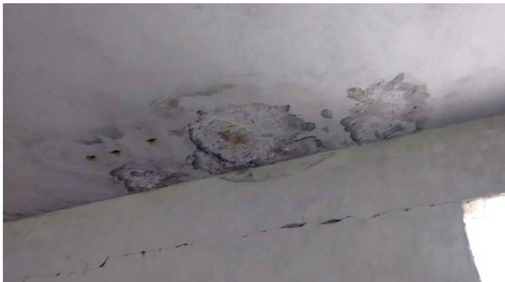
INFILTRAÇÕES NA LAJE DE COBERTURA / TRINCAS NO ENCUNHAMENTO
