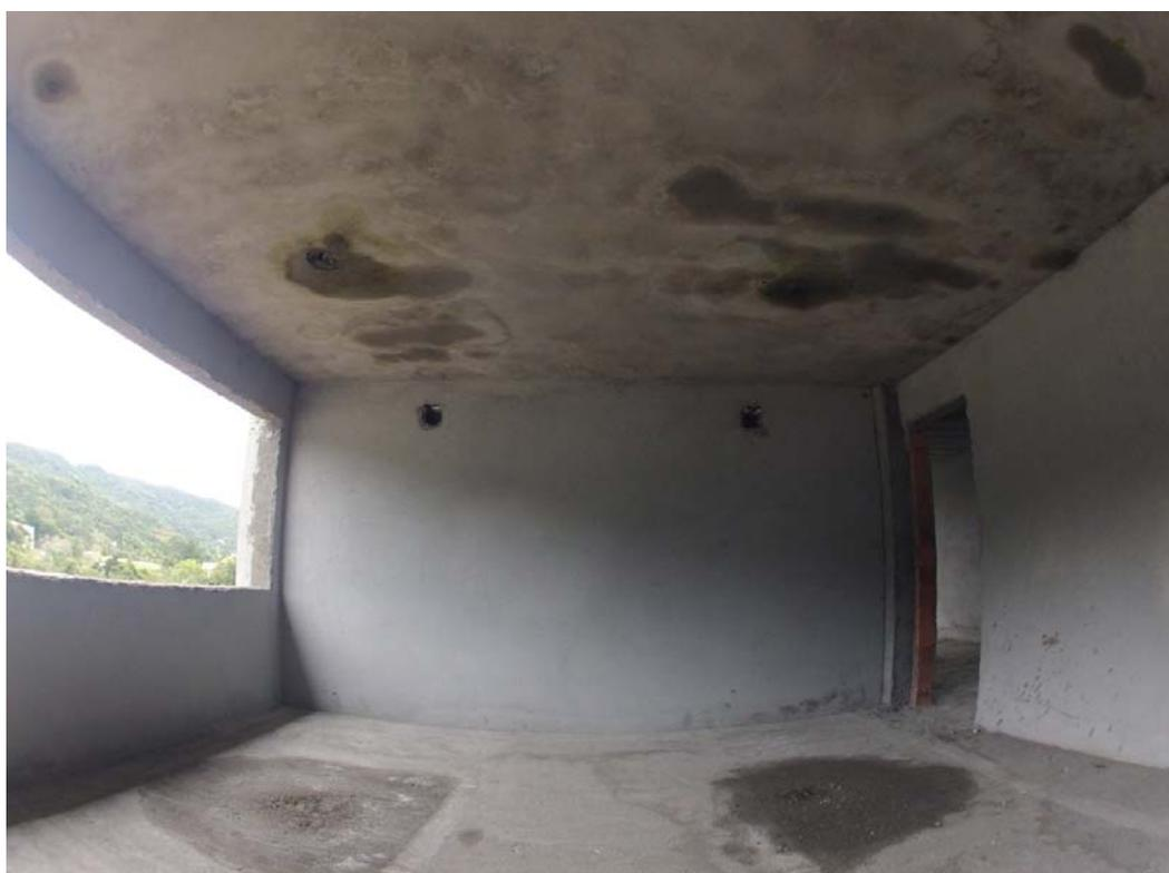
INFILTRAÇÃO NA ÚLTIMA LAJE DO BLOCO "A"
