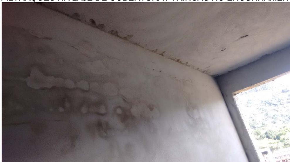
INFILTRAÇÕES NAS PAREDES / TRINCAS NO ENCUNHAMENTO
