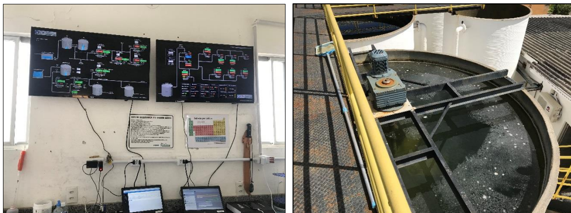
Figura 74 – Estação de Tratamento de Água – ETA ZIMBROS.
