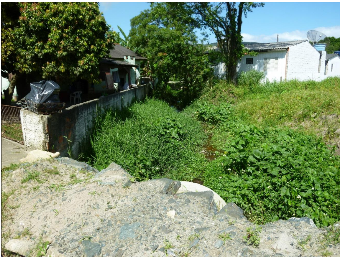
Figura 172 – Descarte de Esgoto em córrego Rua Martim Pescador.
