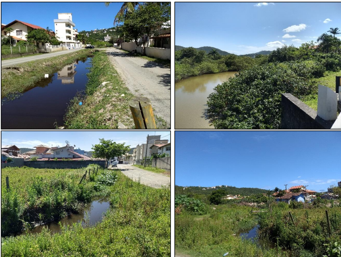
Figura 136 – Canais de drenagem.
