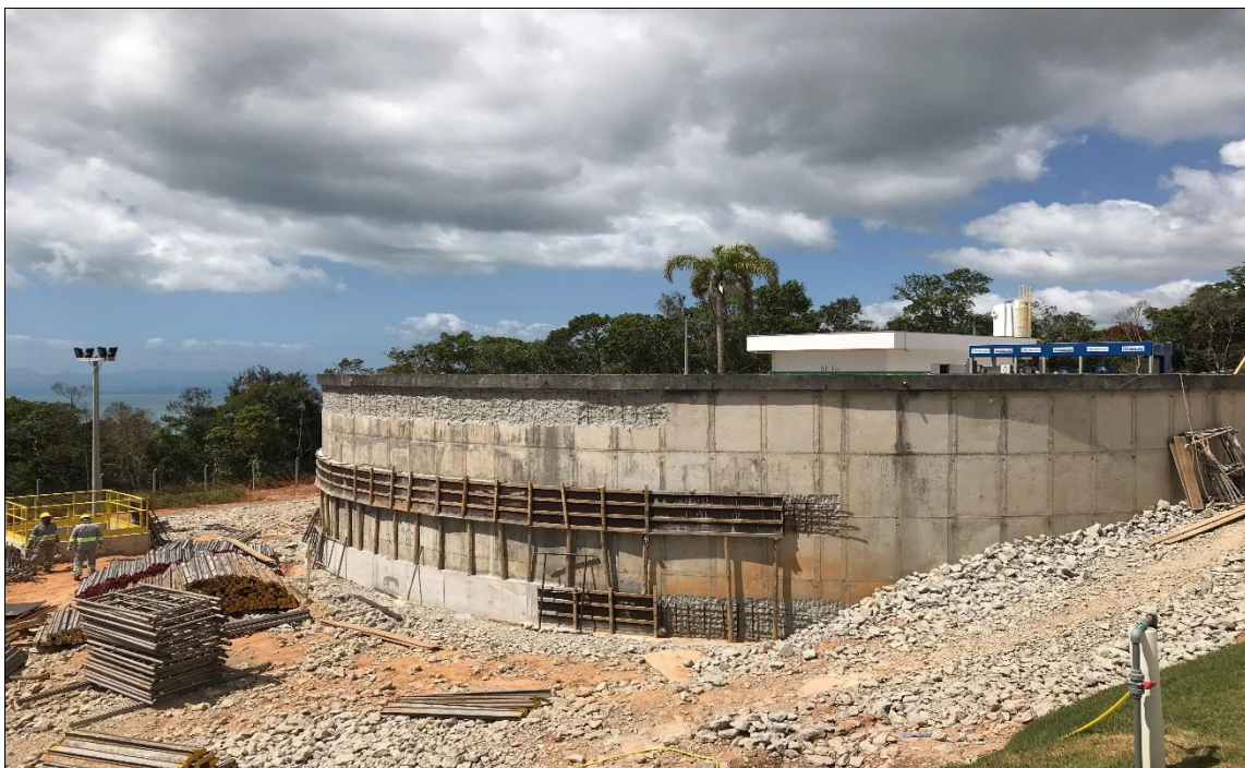
Figura 72 – Decantador em construção.
