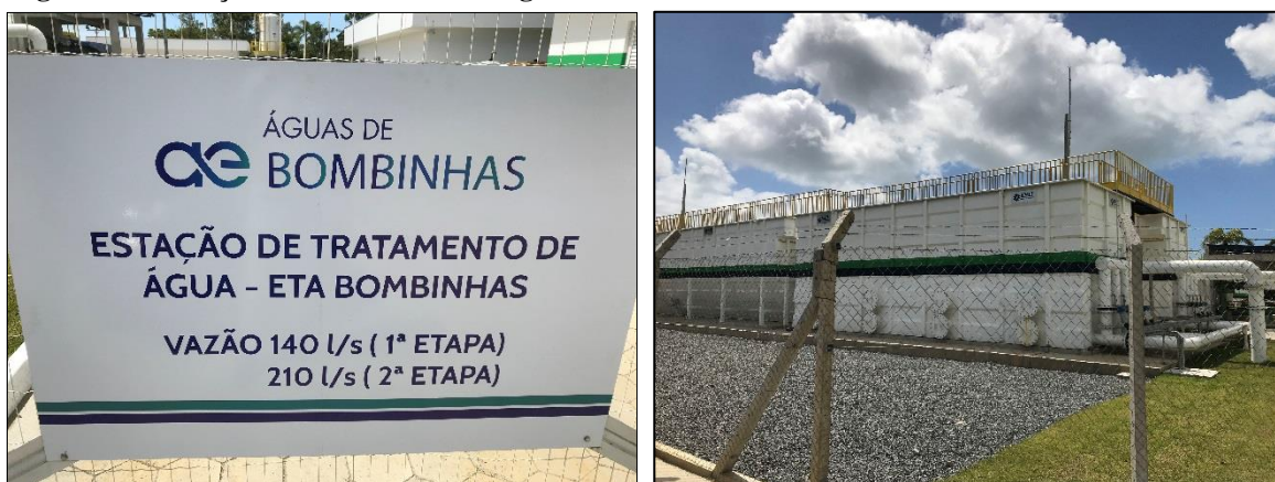
Figura 70 – Estação de Tratamento de Água – ETA BOMBINHAS.
