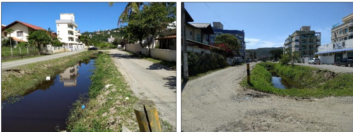
Figura 37 – Aspecto do canal de Drenagem “Vala da Avenida Fragata”.
