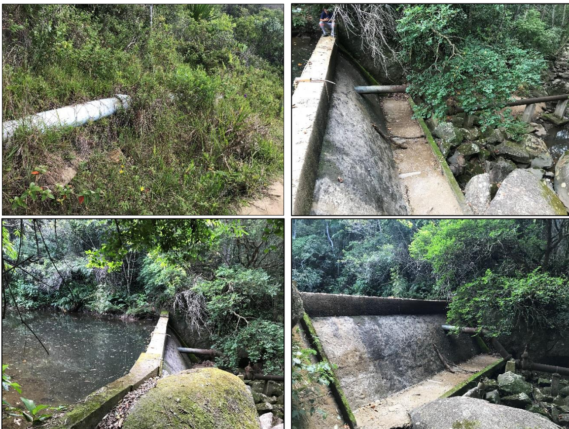
Figura 69 – Captação de Água.
