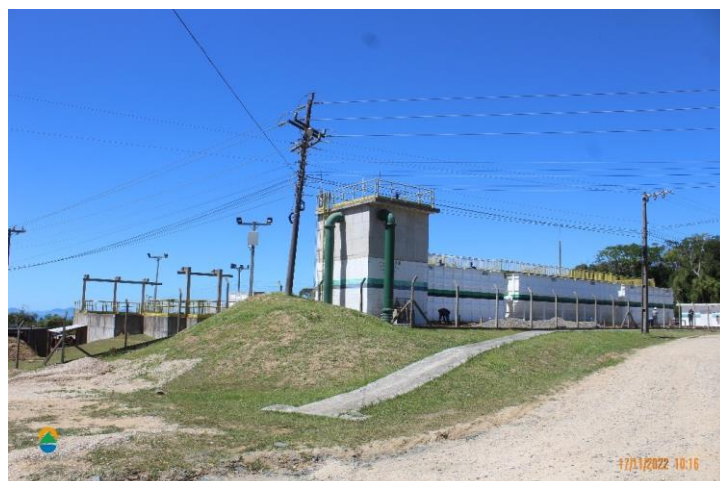
Estação de tratamento de água – ETA Bombinhas (Eco Litoral, 2022).
