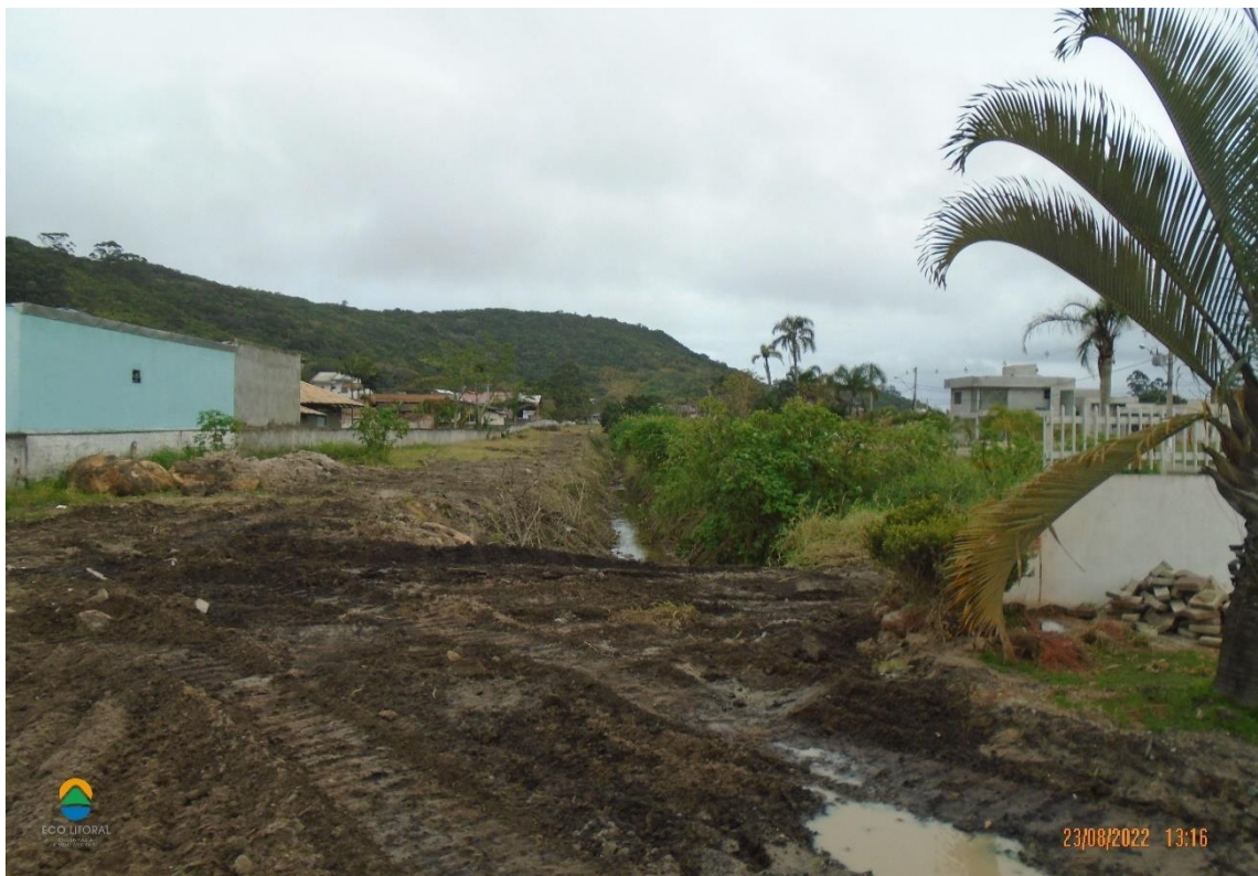
Obra de canalização de curso d'água (Eco Litoral, 2022).
