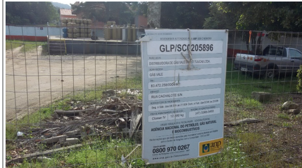
Depósito de GLP (classe IV - capacidade: 12.480 kg).
