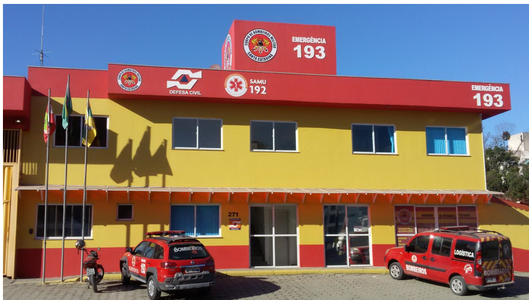
Imagem: Defesa Civil de Bombinhas - Quartel dos Bombeiros (DCB, 9/10/2019).
