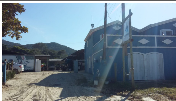
A Marina Norte Sul vista na Praia de Zimbros.
