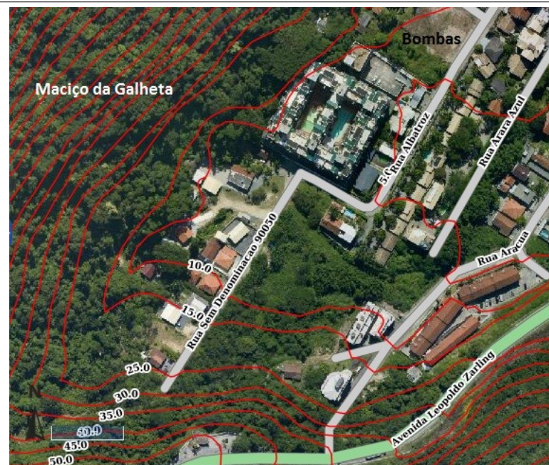
Área de risco de deslizamento (D6), Maciço da Galheta em Bombas (SIG Geo Bombinhas).
