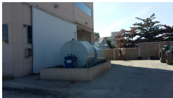
Os tanques de gasolina: 5 mil e 7,5 mil litros:
